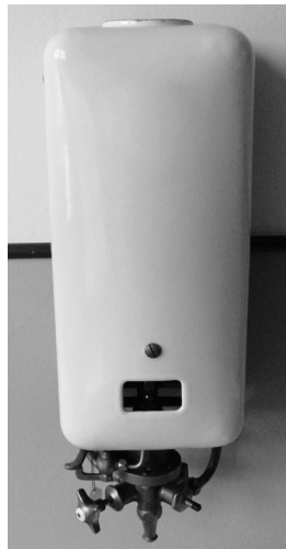
Ejemplo de producción de agua caliente instantánea: termo a gas
