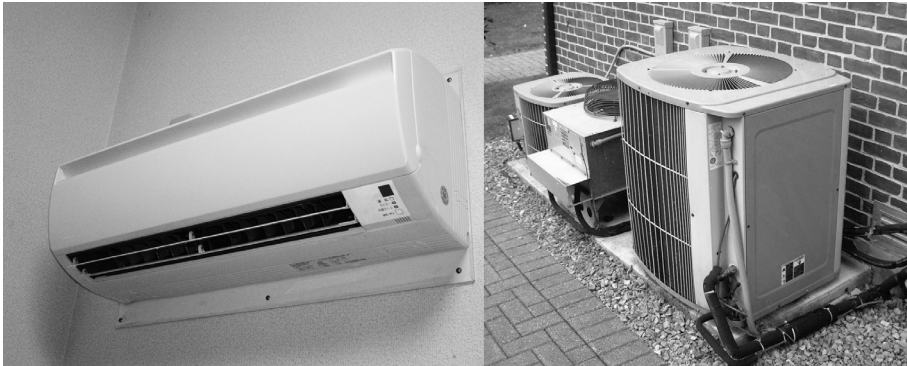
Unidad interior y exterior de aire acondicionado
