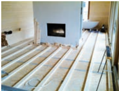
Colocación de tarima con doble enrastrelado.
