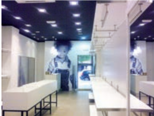
Detalle de instalaciones en un local.
