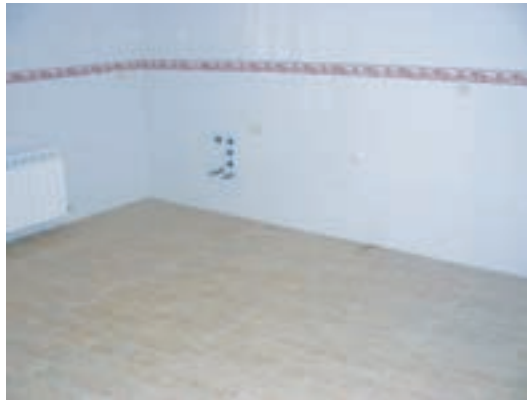
Cocina sin amueblar, donde se pueden apreciar las distintas instalaciones.
