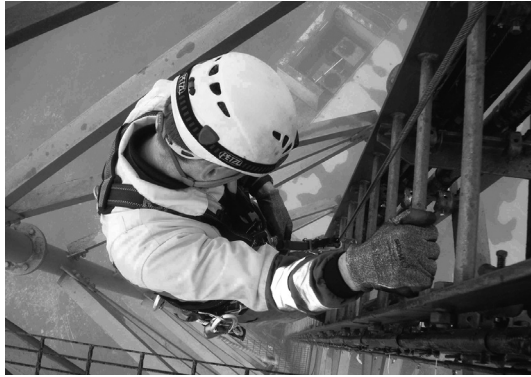
Trabajador enganchado a una línea de vida vertical
