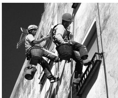
Trabajadores realizando tareas verticales mediante cuerdas.
