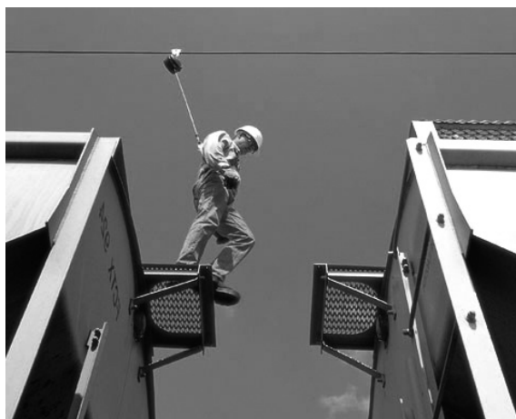
Trabajador enganchado a una línea de vida horizontal
