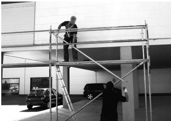
Operarios procediendo al desmontaje del andamio tubular.
