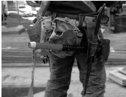
Es muy aconsejable que el trabajador utilice un cinturón portaherramientas en la plataforma de trabajo.
