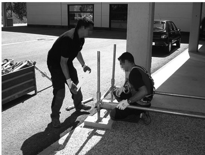
Comienzo del montaje de un andamio tubular: los montadores están haciendo uso de tablas.
