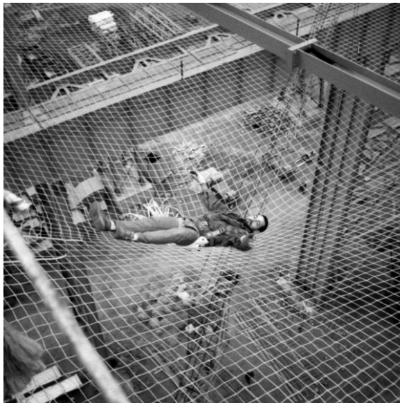
Red de seguridad en obra de construcción: ha evitado el impacto contra el suelo del trabajador.
