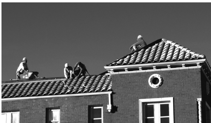
Para realizar las tareas en superficies horizontales de altura nunca se trabajará solo.
