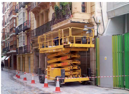
Área de seguridad delimitada por medio de conos y cinta
