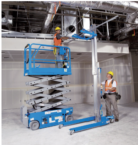
Trabajadores en la plataforma de trabajo y en los alrededores del radio de acción de la máquina equipados con ropa de trabajo adecuada
