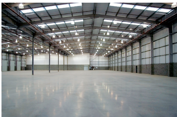
Buena iluminación en un lugar cerrado: natural (aberturas en el techo) y artificial (focos colgados de la estructura superior)
