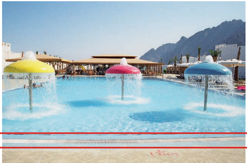
Rebosadero continuo de una piscina de uso colectivo
