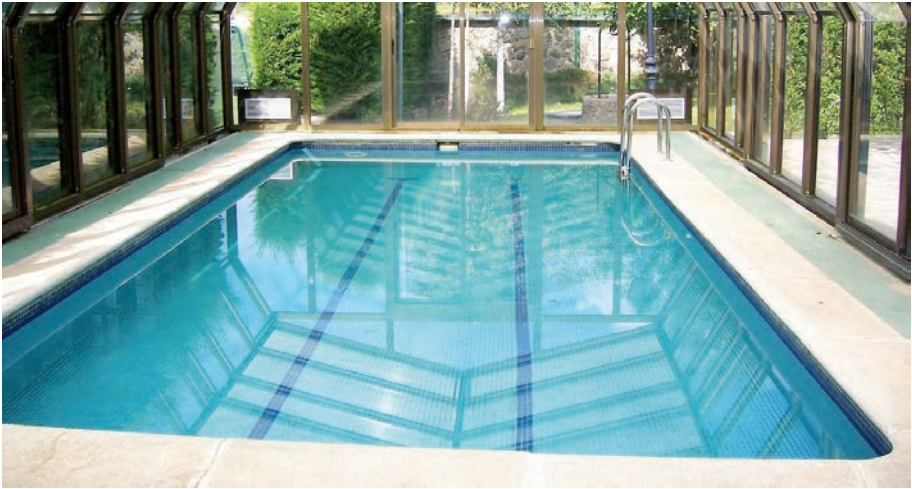
Marcas en el fondo del vaso óptimas para comprobar visualmente la transparencia del agua.
