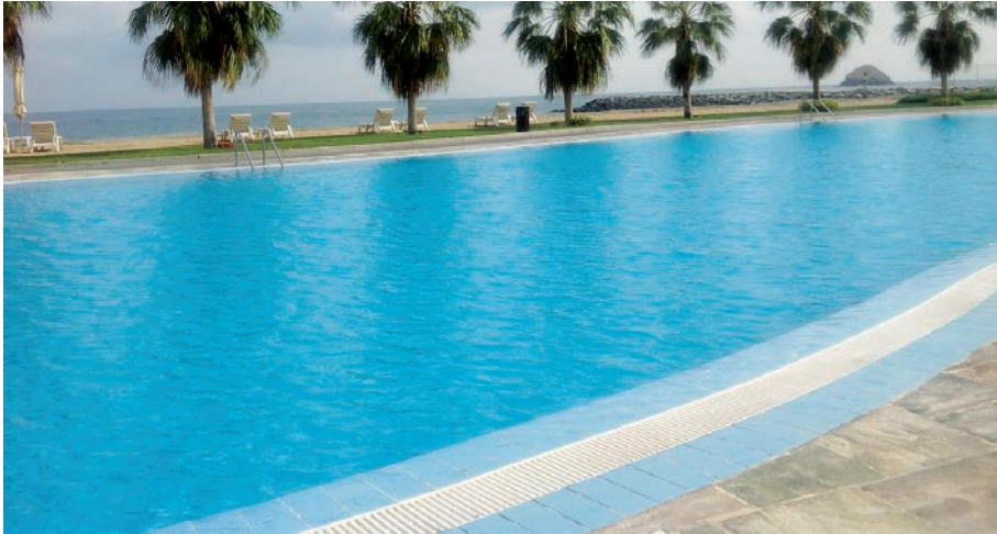
Agua a ras de los rebosaderos
