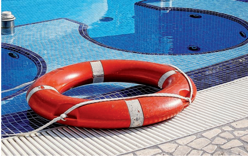
Rebosadero protegido con rejilla
