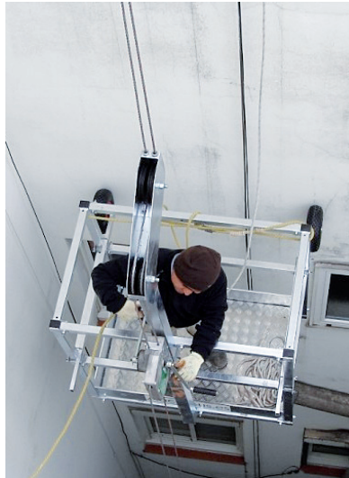
Operarios en andamio colgado móvil de accionamiento manual
