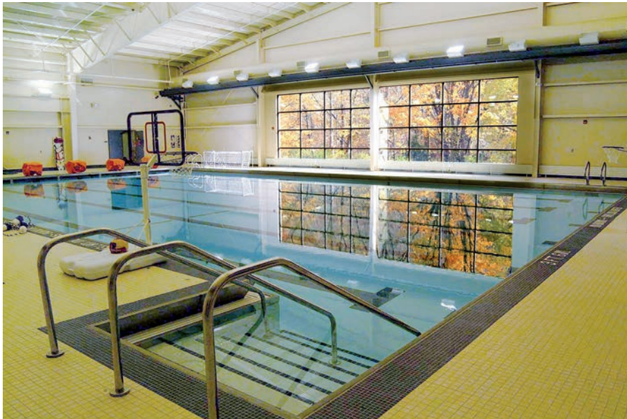
Escaleras fijas de obra con pasamanos
