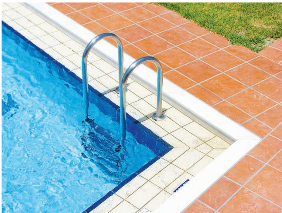
Escalera desmontable: de material inoxidable, empotrada en sus extremos, peldaños planos, antideslizantes, bajo el agua y no sobresaliendo del plano de la pared del vaso. Como aspecto negativo hay que decir que los brazos poseen la misma altura. (© Fotografía: Clafouti, vía web-CC BY-SA-3.0)
