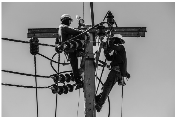
Las cuerdas utilizadas por los trabajadores deben estar homologadas (© Weerawit Samparu / Shutterstock.com).
