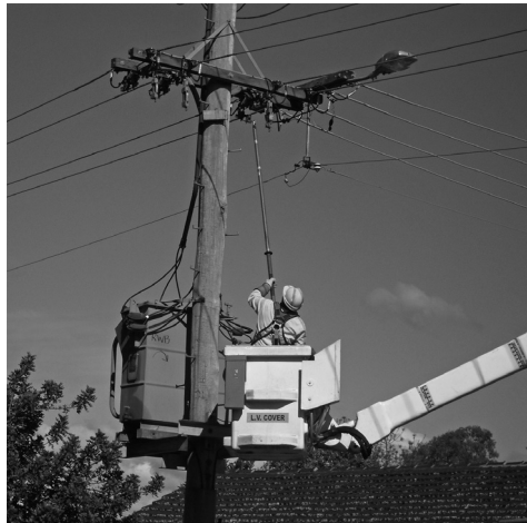
Pértiga no conductora de electricidad utilizada para manipular elementos con tensión eléctrica
