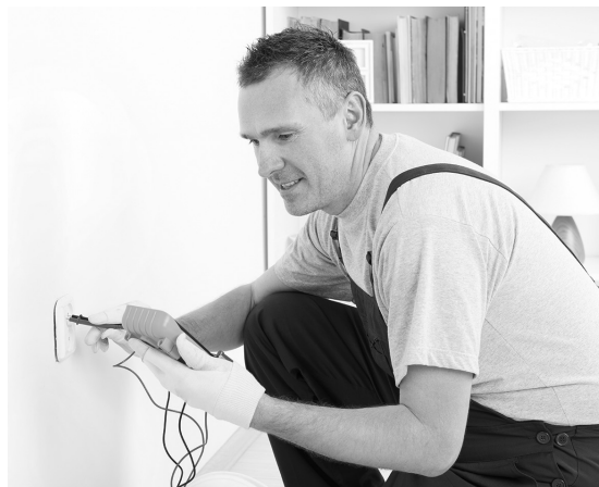
Trabajador verificando la ausencia de tensión.
