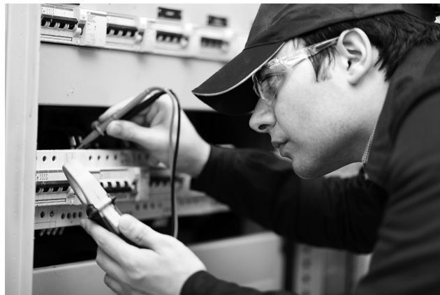
La no utilización de guantes puede provocar un accidente.
