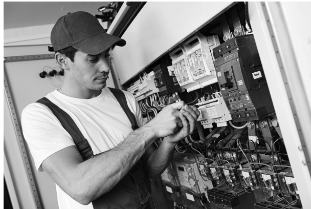
El trabajo eléctrico genera riesgos para los trabajadores.
