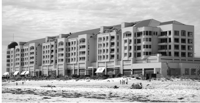
Con la ley de Costas se trata de proteger el litoral de construcciones como la de la imagen que habrán de ser demolidas.
