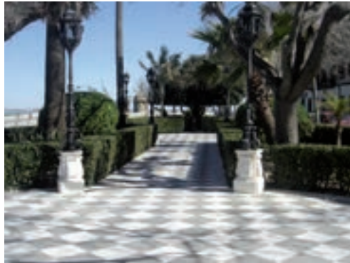
Pavimento con baldosas de mármol
