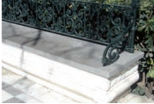
Detalle de banco clásico que combina base de hormigón, mármol y respaldo de fundición
