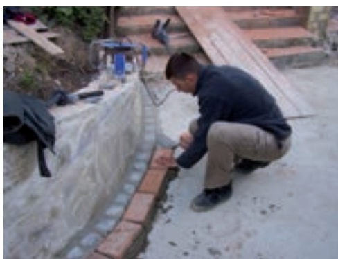
Colocación de ladrillo macizo en pavimento con hilera de adoquines
