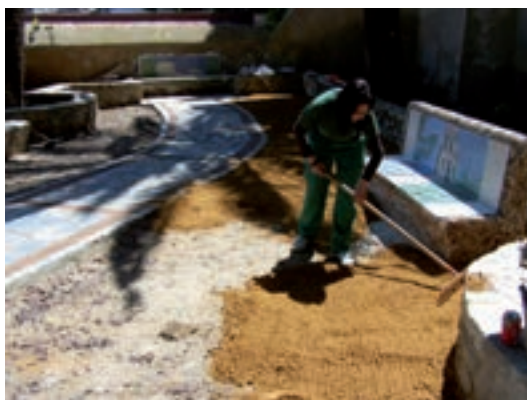
Extendido y nivelado de albero
