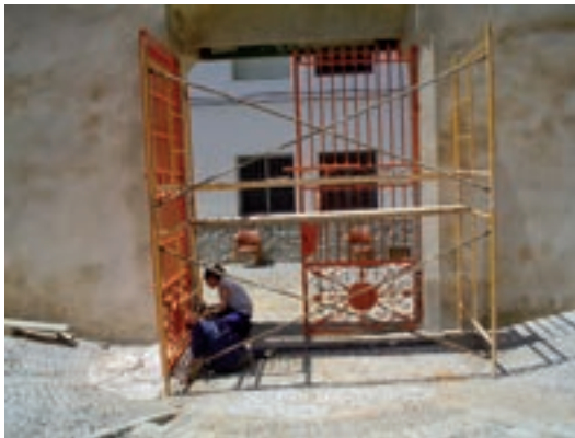
Tratamiento preventivo de cancela de hierro fundido con pintura de minio
