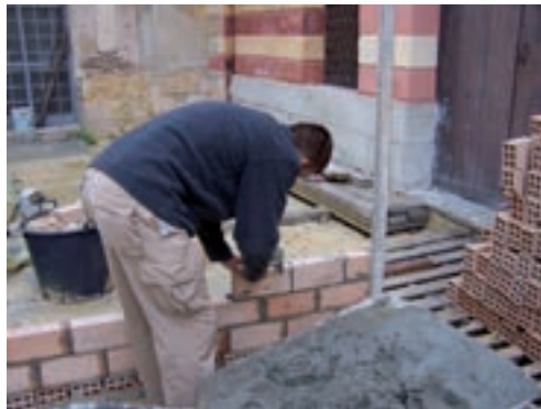
Construcción de tabique con ladrillo de hueco doble
